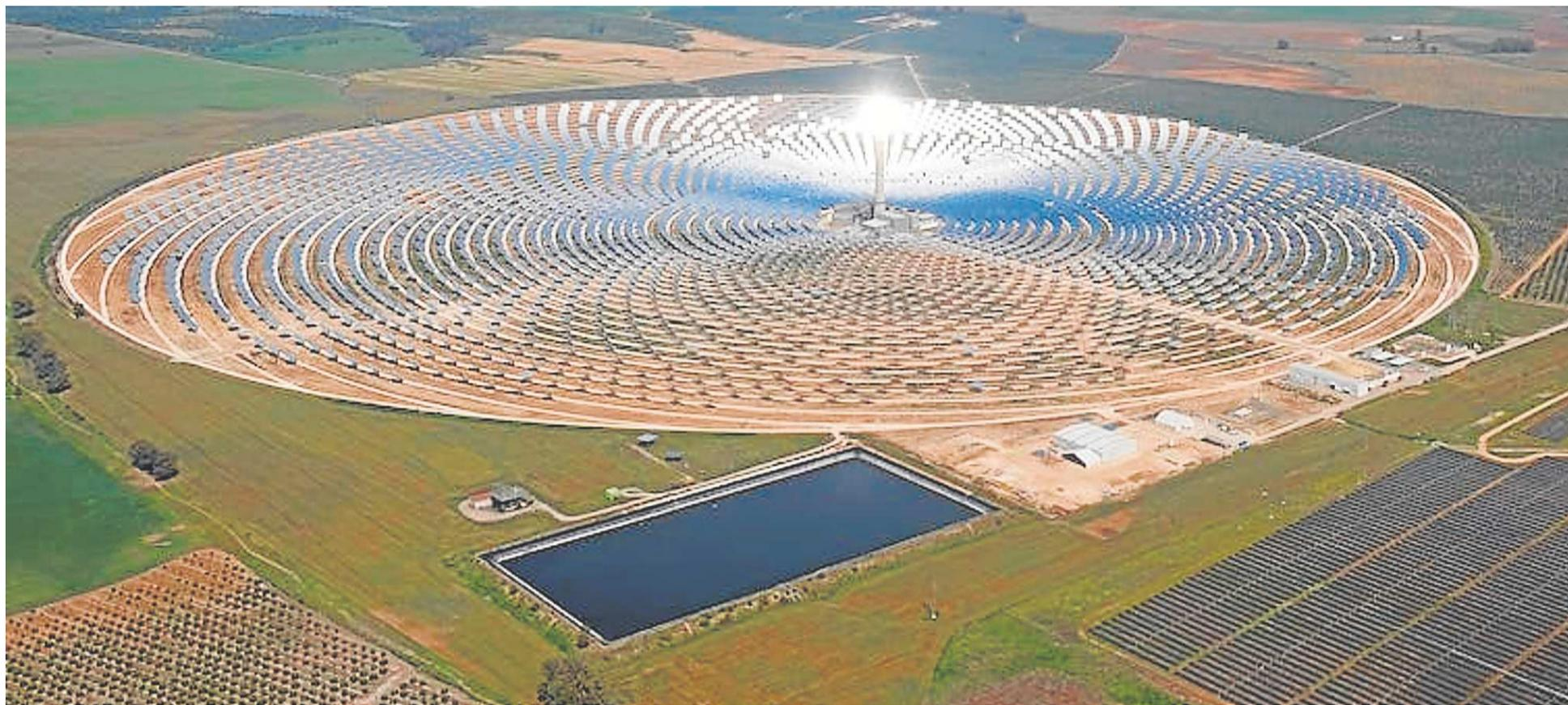
Planta de energía termosolar de concentración con sistema de almacenamiento térmico en sales fundidas en Sevilla. KALLERNA/WIKIMEDIA COMMONS, CC BY-SA
